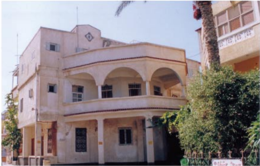
مبنى المطرانية القديم من الجهة الشرقية بعد ترميمه واعداده ليصبح مبنى المكرسات الحالي
